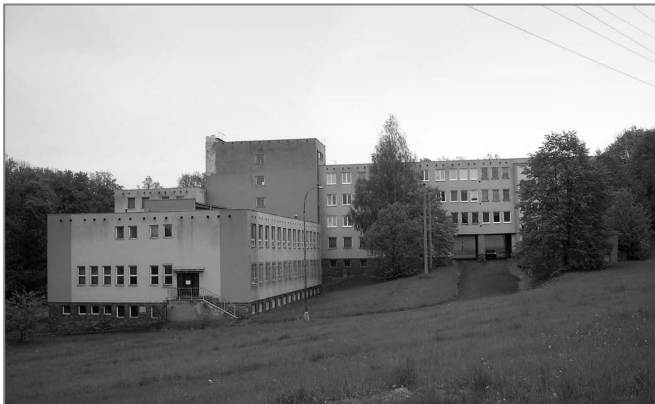
Nynější objekt SOA v Plzni, pracoviště Klášter (u Nepomuka), pohled z jihu, květen 2010
