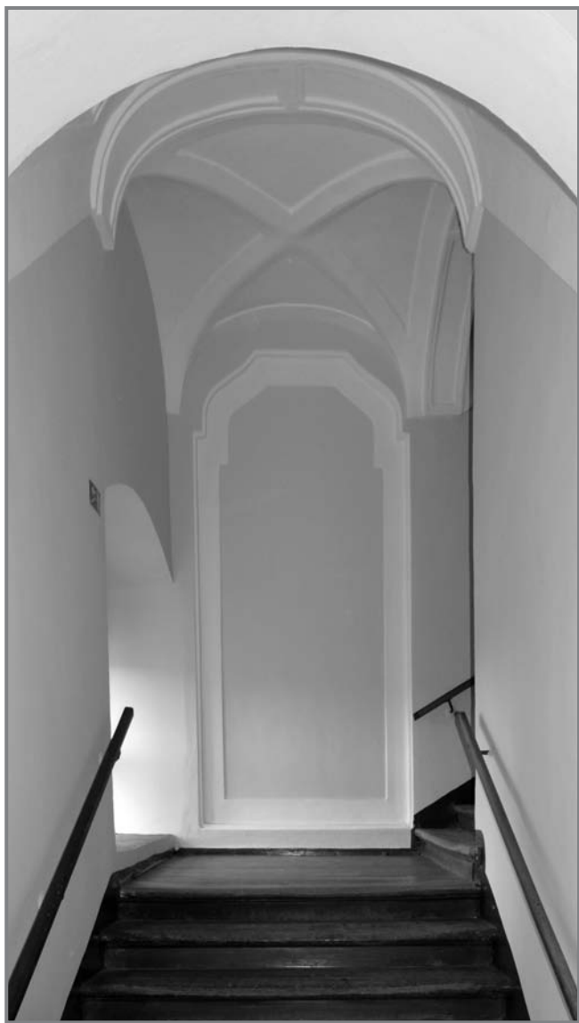
Raně barokní schodiště v hlavní budově zámku v Jindřichovicích s pozoruhodnou štukovou výzdobou, které prošlo v letech 2008 a 2009 opravou
