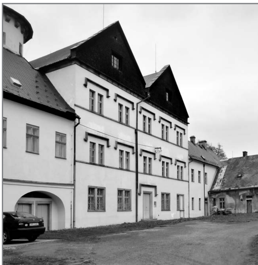
Méně známý pohled na jižní fasádu jindřichovického zámku. Vnější části budovy archivu byly stavebně obnoveny v letech 1996 a 1997, přilehlé neopravené hospodářské stavby patří jiným vlastníkům.
