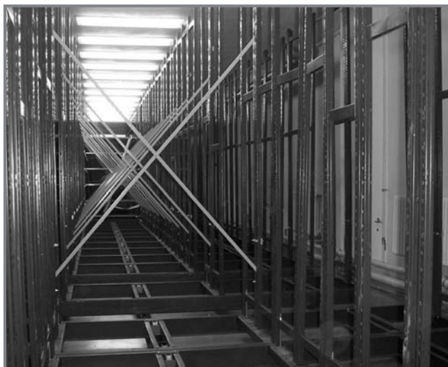
Rozestavěné posuvné regály v podzemí budovy SOA v Plzni, pracoviště Klášter
