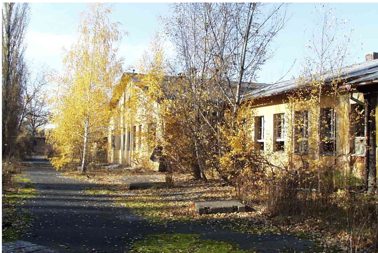
Původní objekty v devastovaném areálu bývalých kasáren v Plzni na Slovanech
