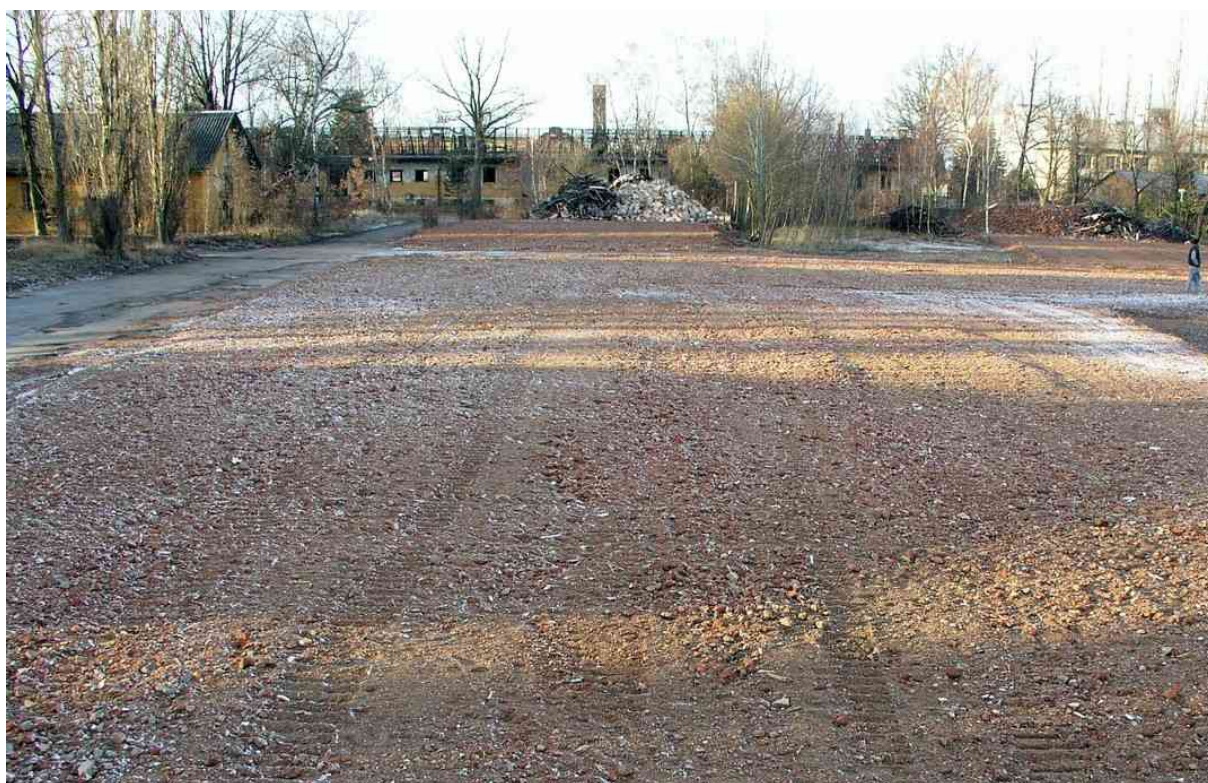
Zplánýrovaný pozemek pro budoucí výstavbu nového Státního oblastního archivu v Plzni
