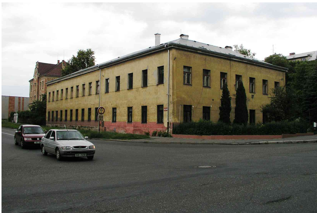
Budova Státního okresního archivu v Karlových Varech
